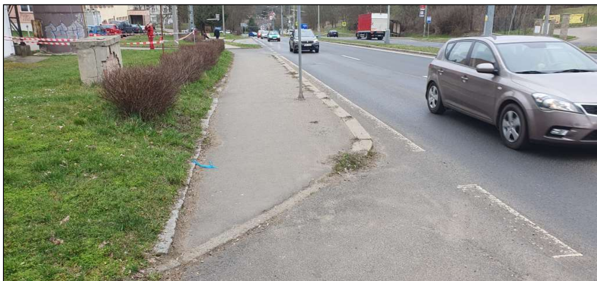
Foto 8 Chybějící úpravy pro nevidomé na všech místech, kde chodník křížuje vjezd do areálu nemocnice
