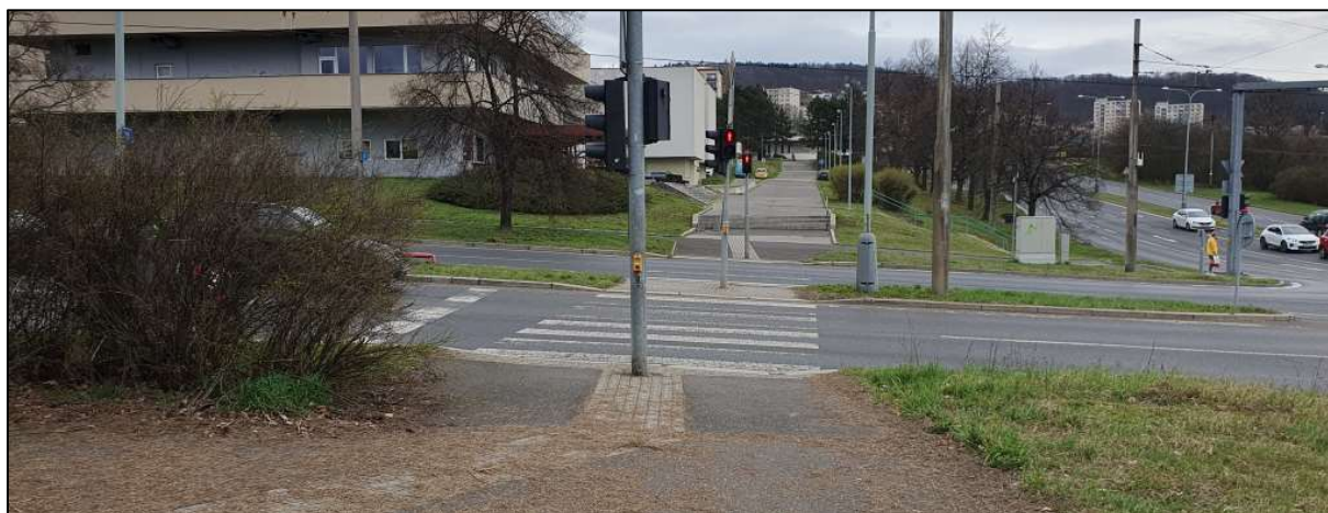
Foto 26 Nenavazující vodící linie na přechodu přes ulici Sociální péče
