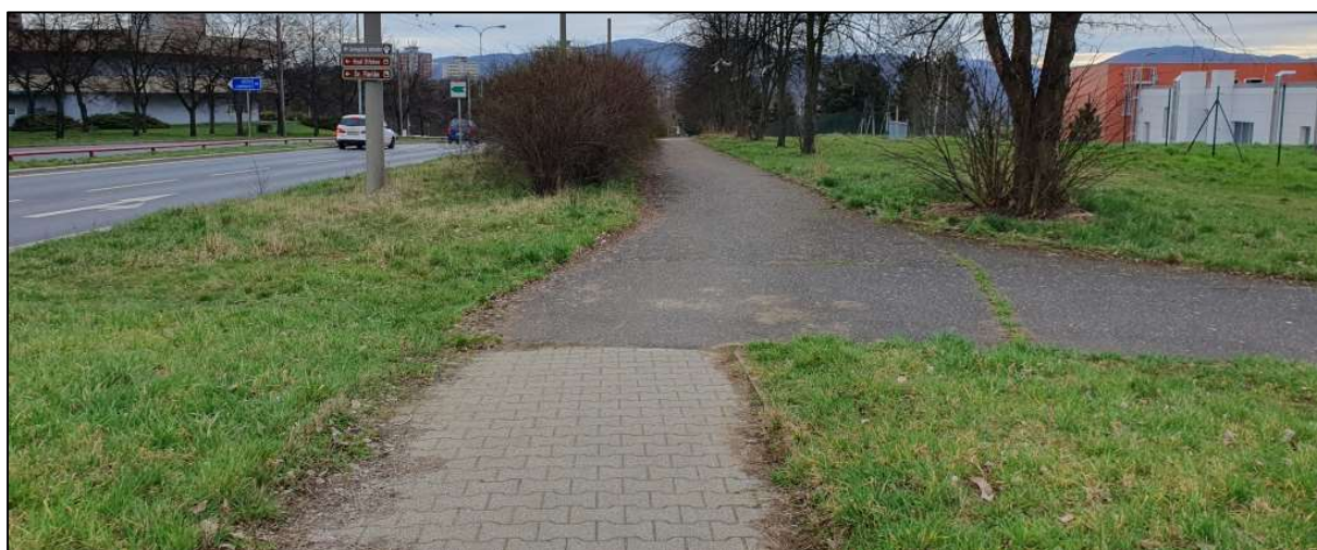
Foto 27 Příklad nenavazující přirozené vodící linie na úsecích mezi řešenými lokalitami
