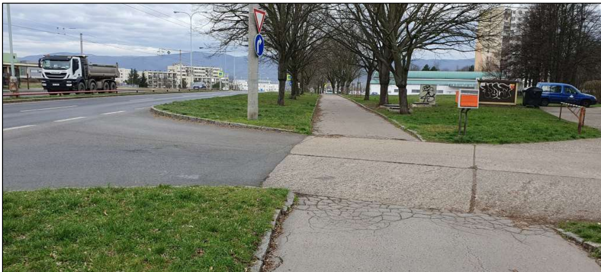
Foto 22 Chybějící varovné pásy při přecházení vozovky - nulový nášlap
