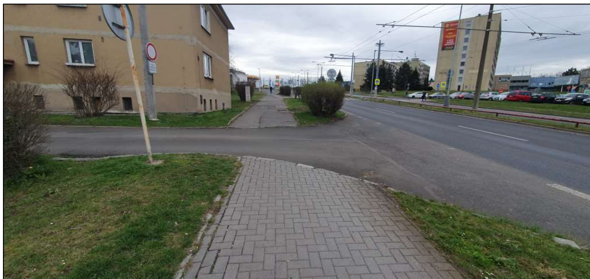
Foto 13 Nedostatečná přirozená vodící linie bez nášlapu + 6 cm u obrubníku
